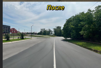
Профессиональный ямочный ремонт асфальтированного полотна
